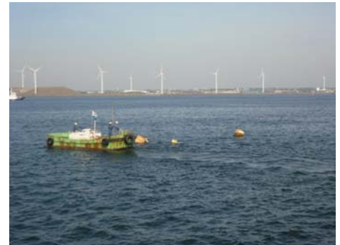
ワイヤー取り付け作業（シンカーブイ）
