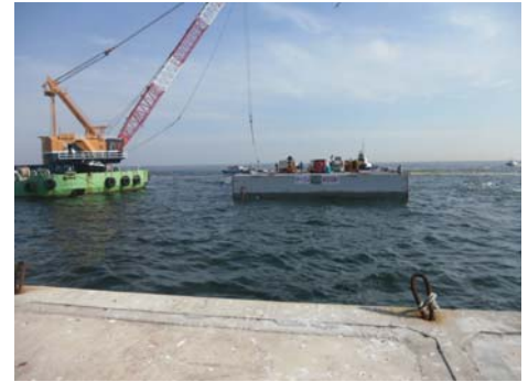
ワイヤー取り付け作業
