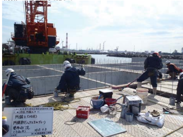
防錆工(2回目)実施状況
