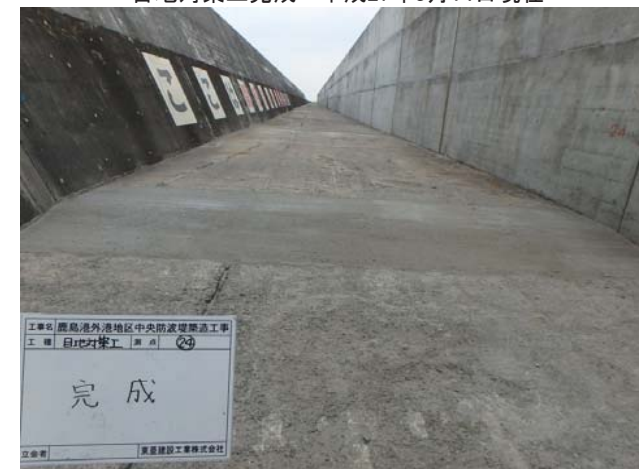
目地対策工完成 平成27年3月14日現在
