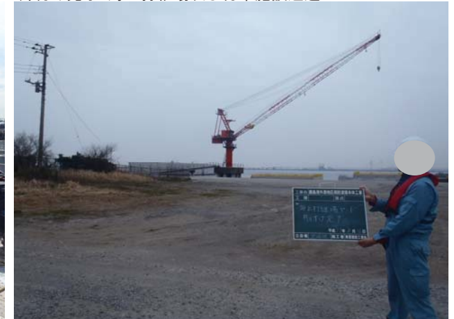
片付け完了・海上打継場及び付帯施設返還
