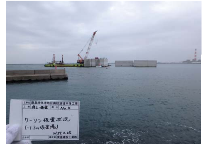
No.4ケーソン仮置き状況
