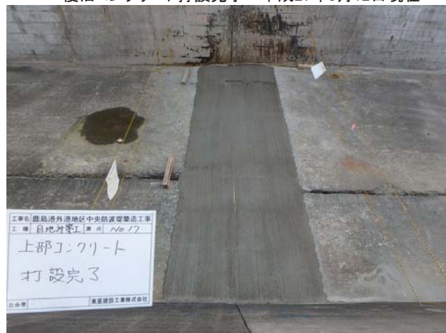
復旧コンクリート打設完了 平成27年3月12日現在
