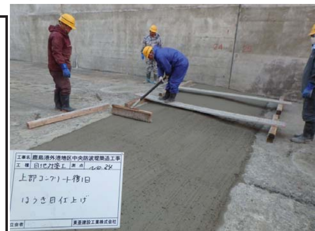
復旧コンクリートほうき目仕上げ 平成27年3月12日現在
