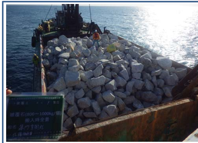
被覆工 被覆石搬入時確認状況 (3月12日撮影)
