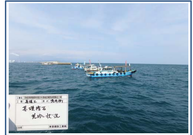
基礎工 捨石荒均し(港内側) (3月14日撮影)
