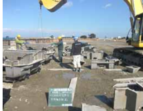
パラクロス4t型 型枠組立状況
