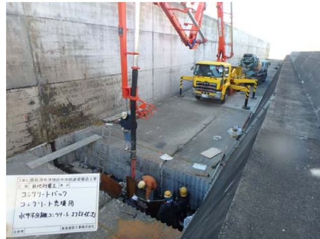
コンクリートバックコンクリート充填 平成27年2月14日現在
