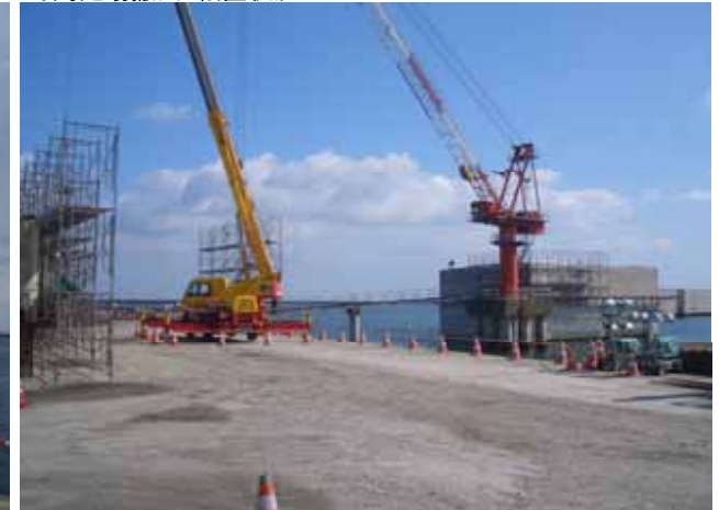
外周足場撤去・転置状況
