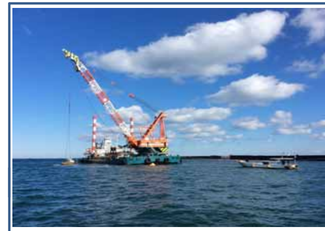
シンカー撤去状況(港内)
