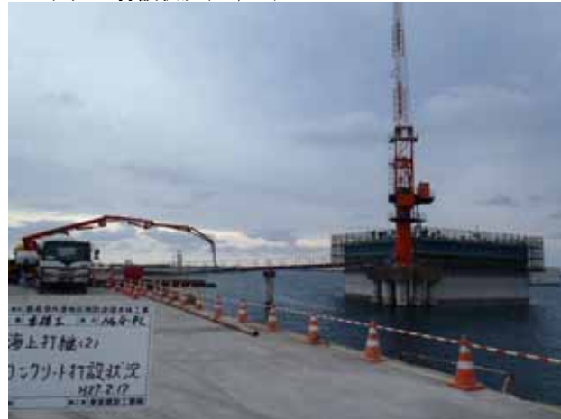
コンクリート打設状況(No.4-8)
