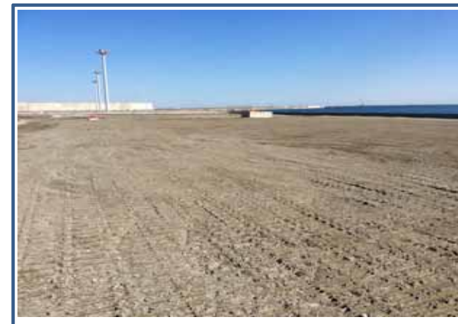
外港地区整地完了
