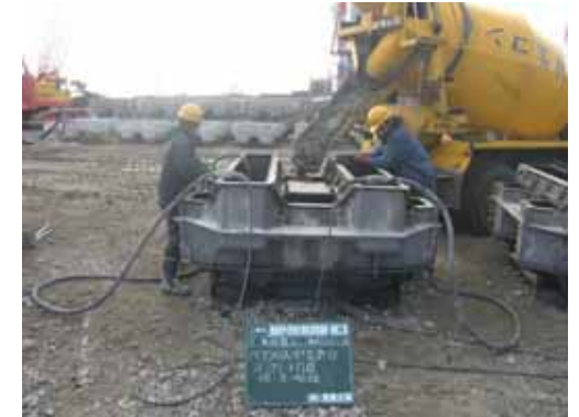
パラクロス4t型 コンクリート打設状況
