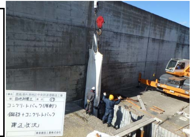
鋼材+コンクリートバック建込状況 平成27年2月14日現在
