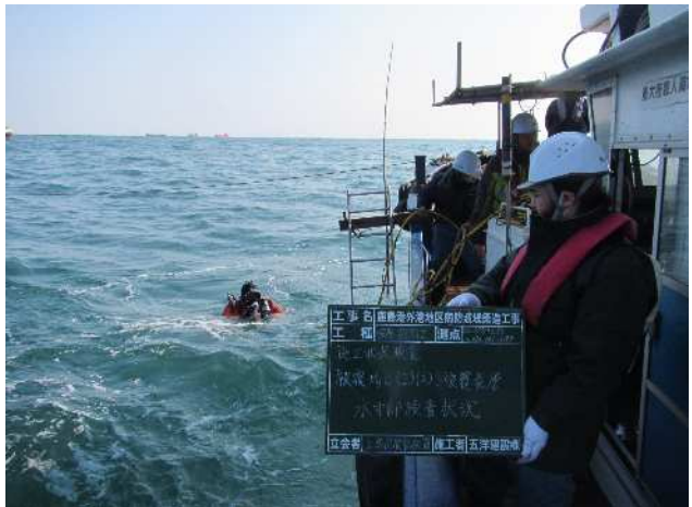
被覆・根固工 被覆均し(港内側)水中部検査状況
