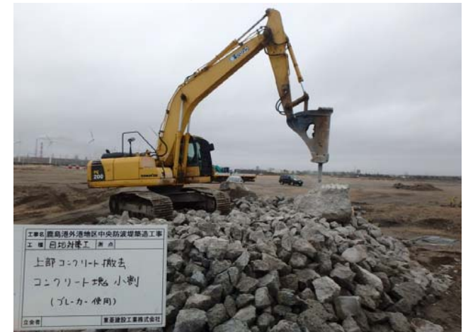
コンクリート塊小割状況 平成27年2月18日現在
