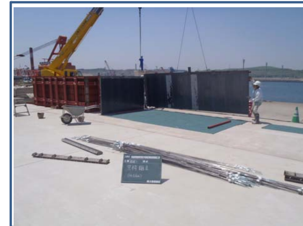
型枠組立状況
