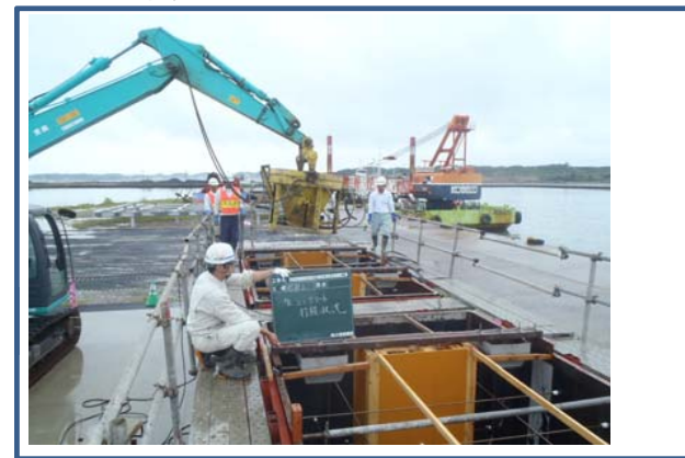
生コンクリート打設状況
