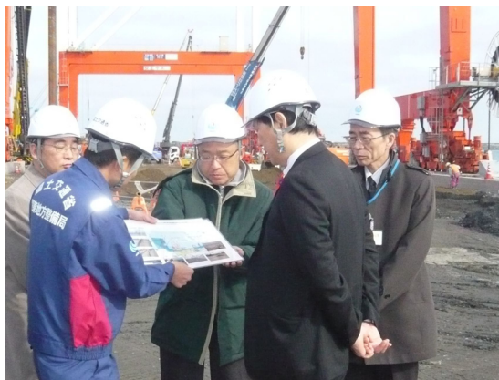
港湾施設の被災状況について説明を受ける末松復興副大臣
