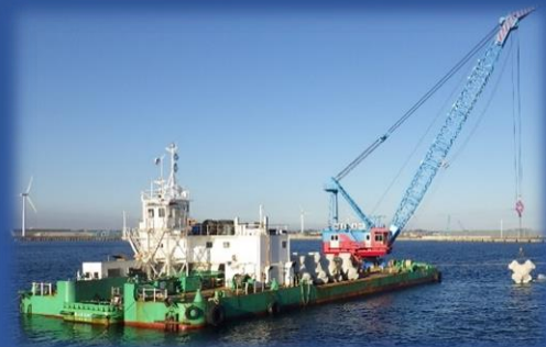
大きな消波ブロックも吊り上げる起重機船。
