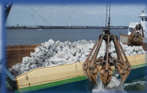
クレーンを使って、 石を海に投入します！
