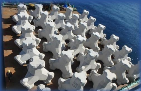
起重機船上に並ぶ消波ブロック。
