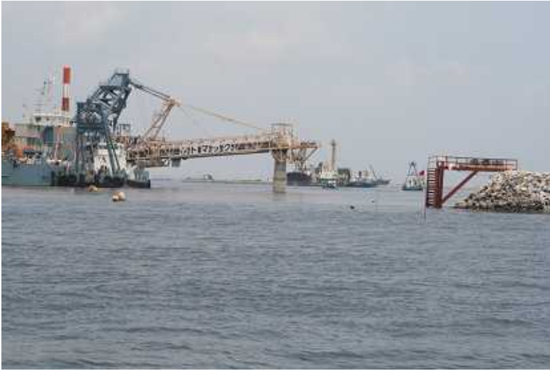
図1 トレミー船による施工状況(8月21日)
