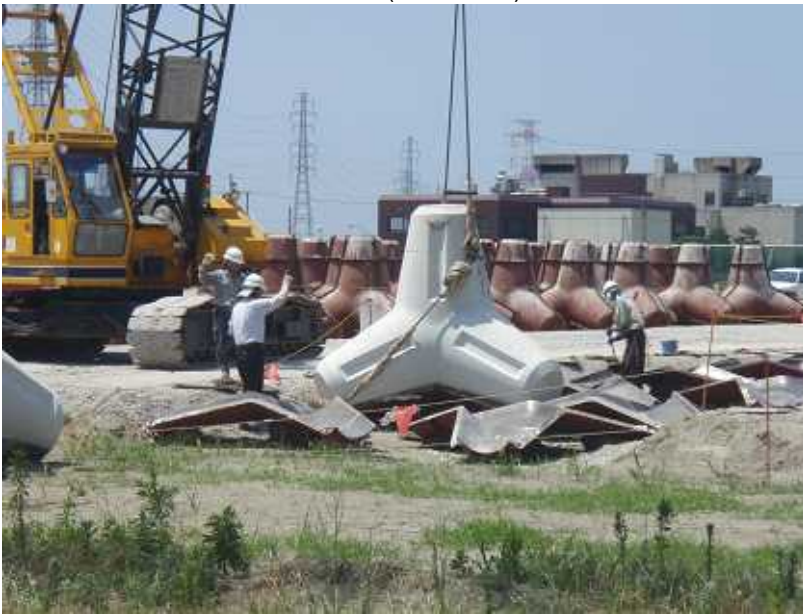
図2 環境共生型消波ブロックの製作状況
