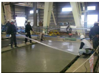
養生シート取付
