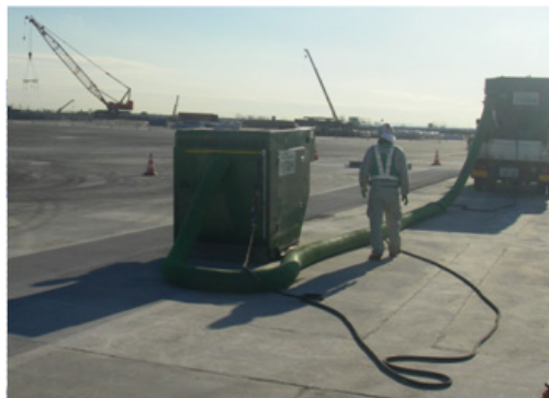
ショットブラスト施工状況
