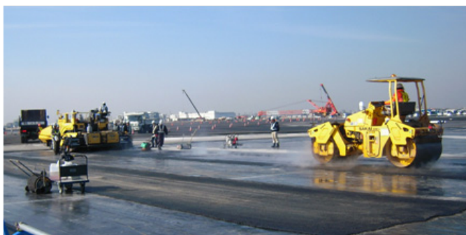
SMA施工状況
