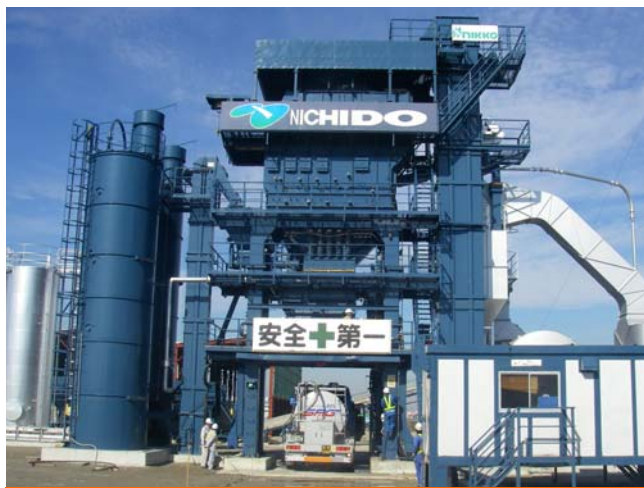
写真； プラント2号基
