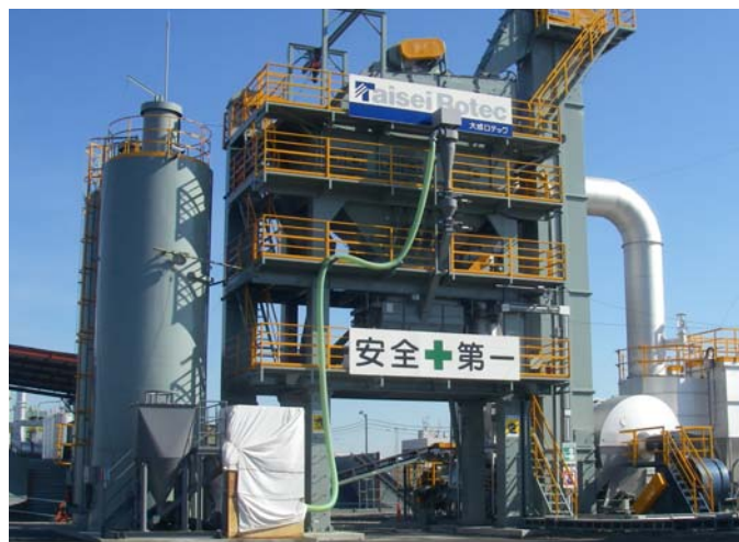
写真； プラント1号基
