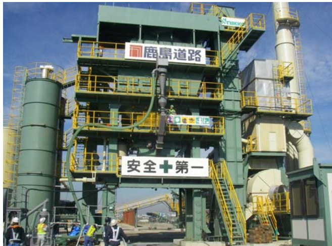
写真； プラント3号基
