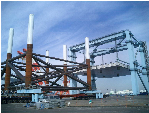
ジャケット一体化施工状況
