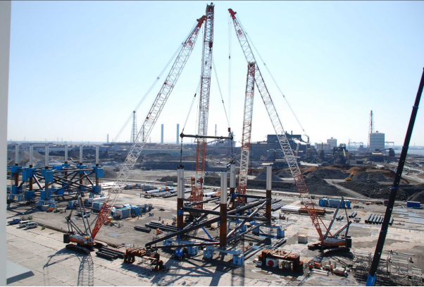
下部ジャケット施工状況
