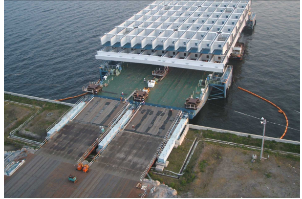
上部ジャケット搬入状況
