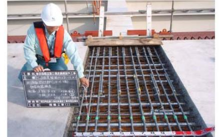
鉄筋組立状況(滑走路直角方向)
