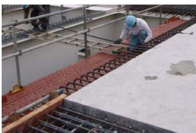
PC鋼より線挿入状況
