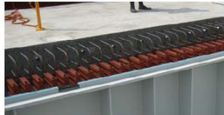
箱抜きボックス設置・PCa床版据付
