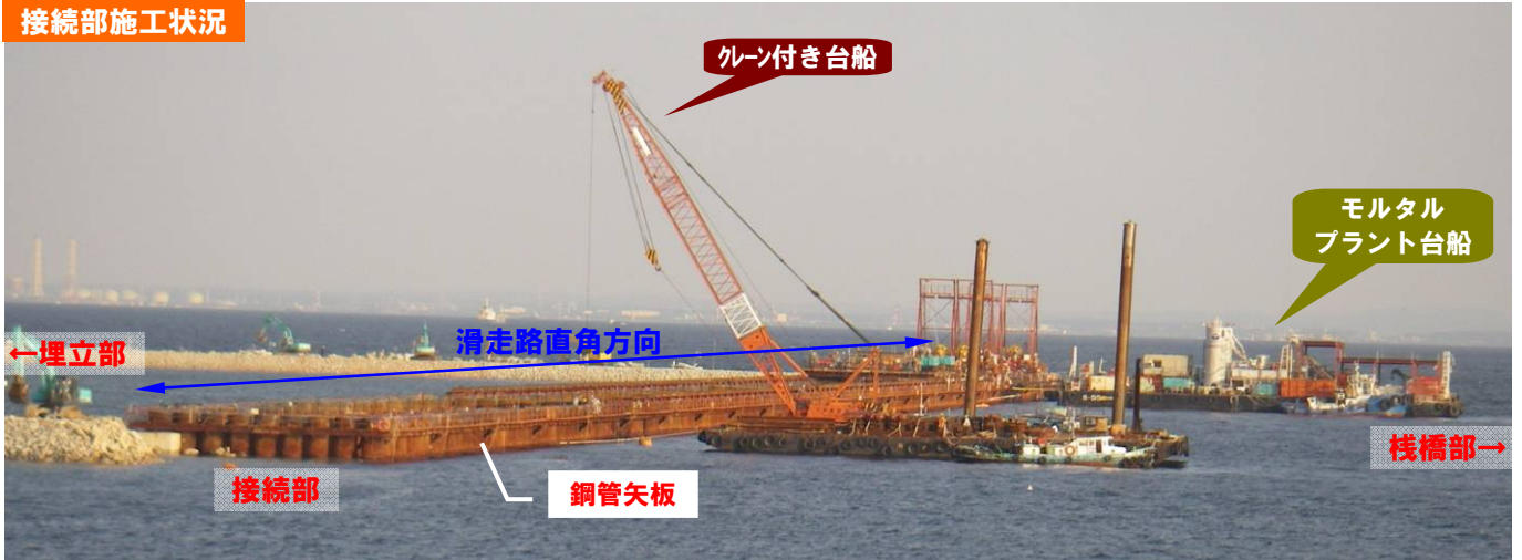
継手処理工施工状況
