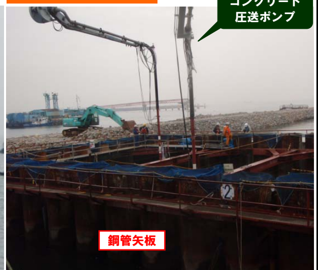
コンクリート打設状況
