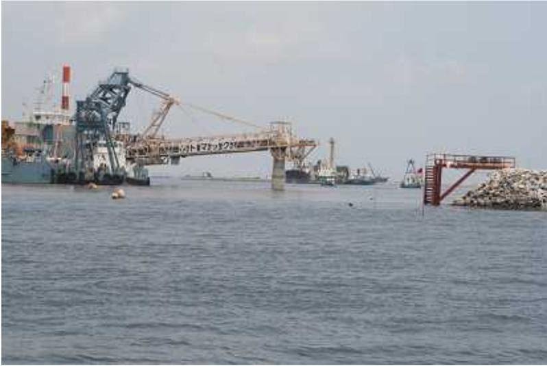
筒状の管を海底面付近まで挿入し、管の中に護岸埋立工事に使用する岩ズリ・山砂を徐々に投入することにより、濁りの発生を抑制できる
