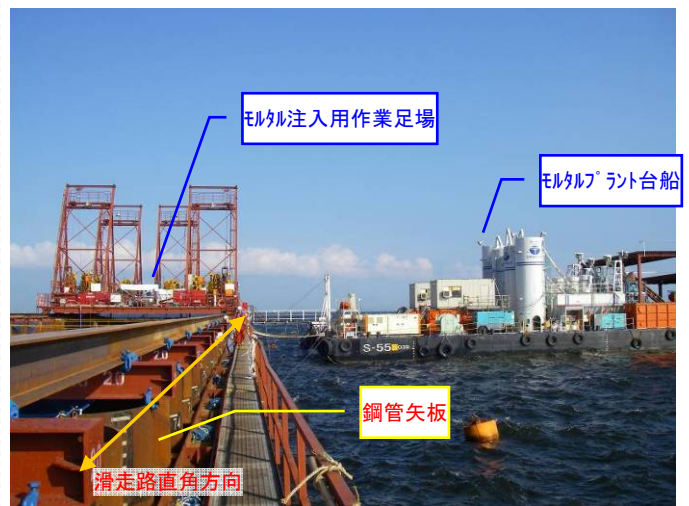
継手処理 (モルタル注入) 施工状況
