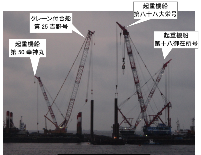
鋼管矢板打設状況 (6:00 頃)
