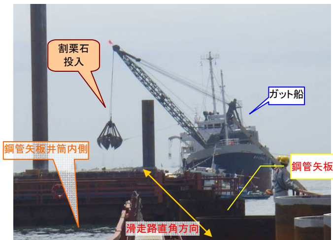
中詰工 (割栗石) 投入状況
