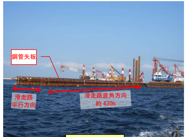
鋼管矢板屋間状況
