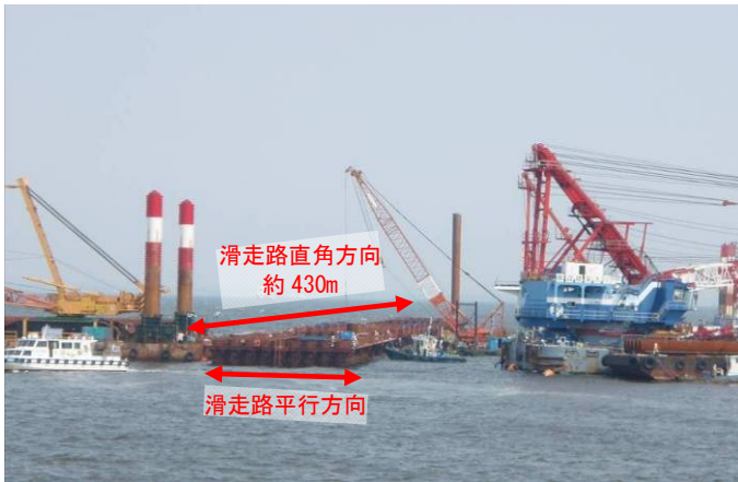
鋼管矢板屋間状況
