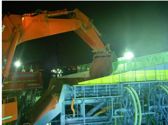
ホッパー投入状況
