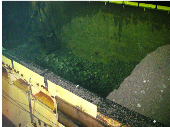
運搬船土取り状況
