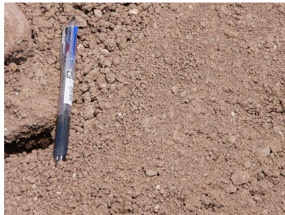
地山の目視確認状況 (遠方からは土に見える部分も、間近で見ると砕いた石の塊)
