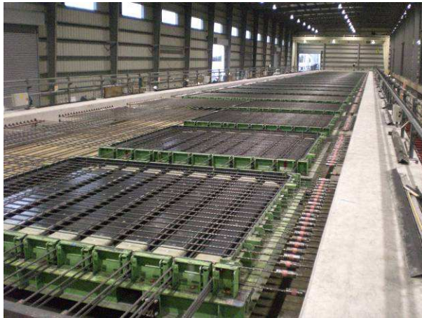
③ 型枠組立～P C鋼線緊張 (20枚の同時製作)
