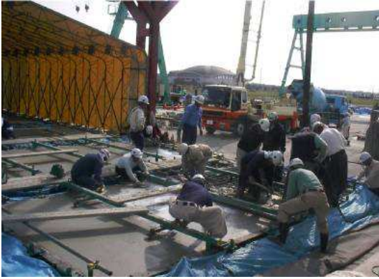
④ コンクリート打設状況
