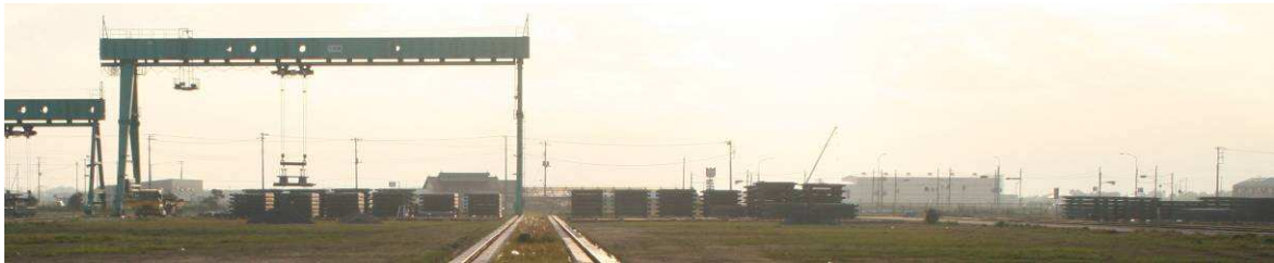
⑧ 工場内 床版仮置き状況
