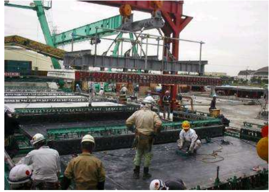
⑤ 型枠脱型、床版移動状況
