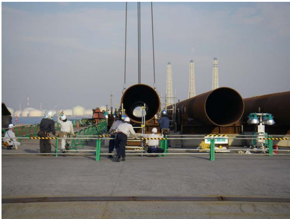
③ 750 t 吊クレーンによる一本化杭吊り上げ準備
