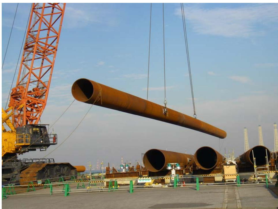
④ 750 t 吊クレーンによる一本化杭吊り上げ状況（長さ：約 90m）
