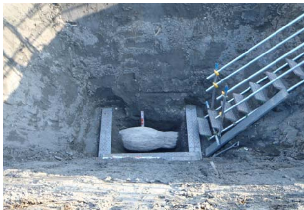
固結体の確認状況
