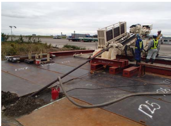
曲がり削孔状況
