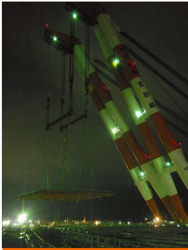
写真；棧橋部ジャケット 150 基目据付状況
