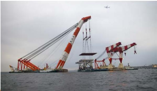
写真；棧橋部ジャケット 150 基目吊り上げ状況
