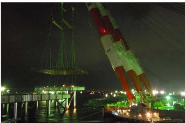
写真；棧橋部ジャケット 150 基目据付状況
