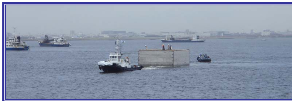
ケーソン曳航(運搬)状況
