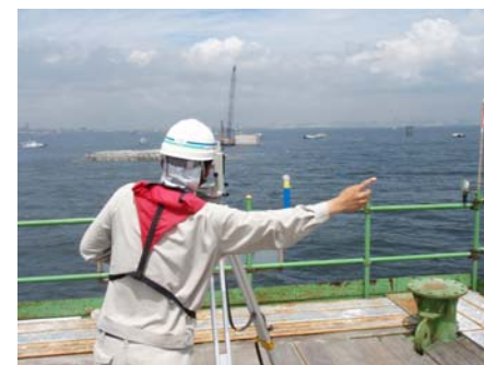
ケーソン据え付け位置確認
