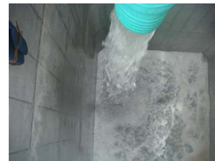
ケーソン内海水注水状況
