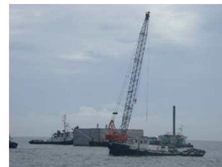
ケーソン据え付け状況
