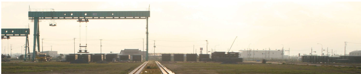
⑧ 工場内 床版仮置き状況
