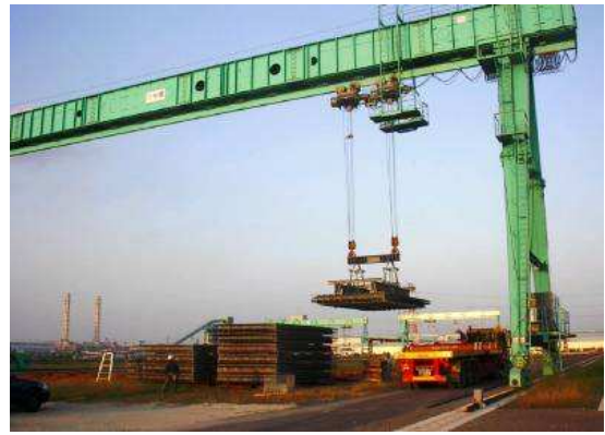
⑦ 工場内 床版運搬状況
