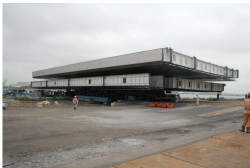
上部ジャケット積み下ろし
