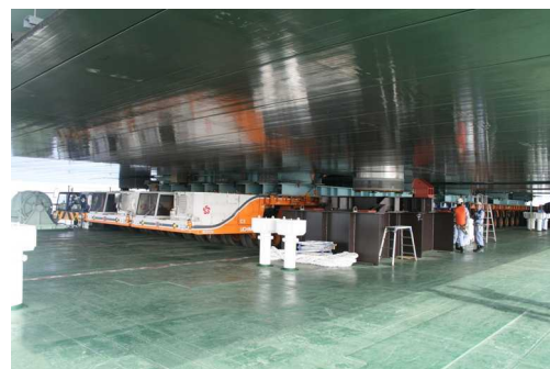
ドーリー据付状況
