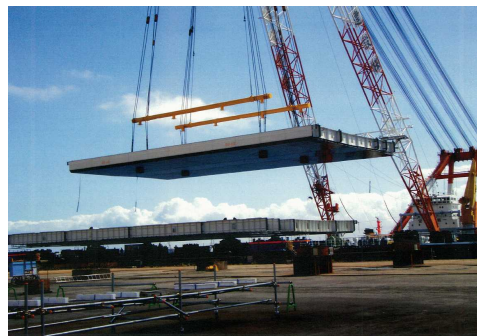
上部ジャケット積み出し（9月15日）
