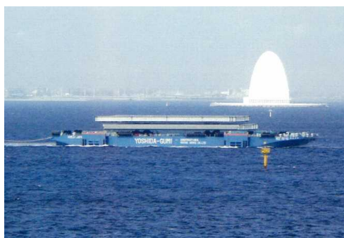
上部ジャケット運搬状況
