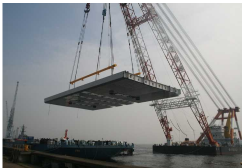
上部ジャケット積み出し（9月14日）
