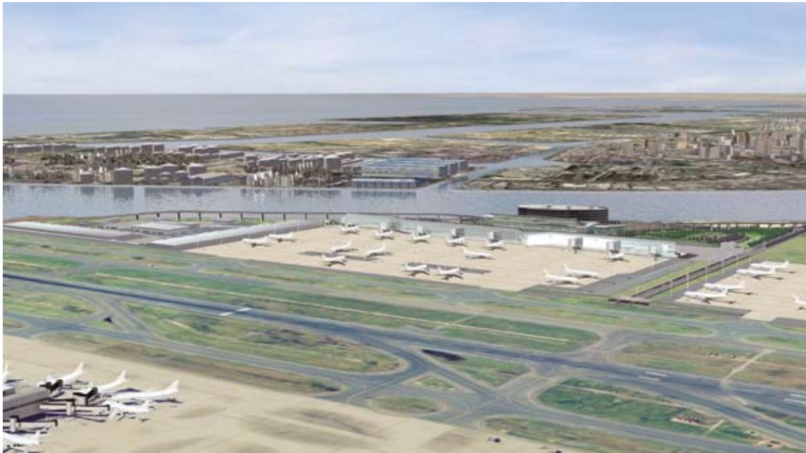
平成19年3月時点 羽田空港国際線エプロンPFI(株)提供
