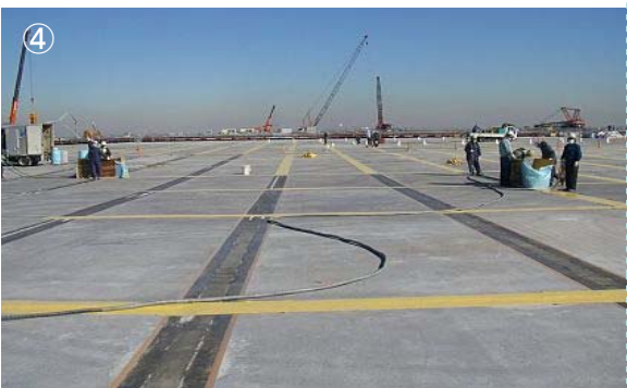
床版を据え付け後の状況
