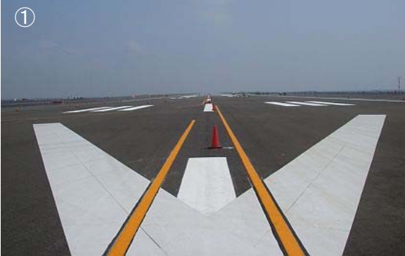
床版上に舗装を舗装した後、標識を施工(2009.12月～)
