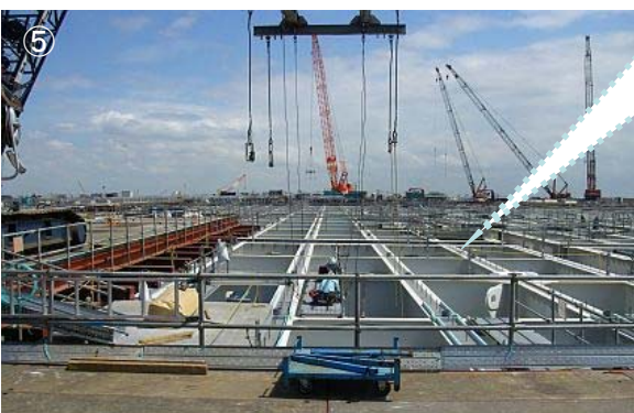
ジャケット上に床版を据え付け開始(2008.3月～)
