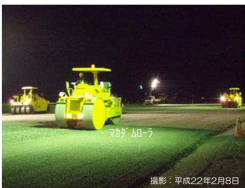
⑤タイヤローにて締め固め後、マカドローにて二次転圧を行います。二次転圧では、表面の不陸整平等（仕上転圧）を行います。
