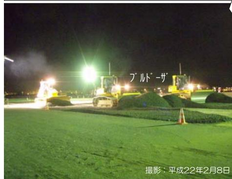
③ダンプトラックにて運搬してきた路盤材をブルドーザやモーターグレーダにて所定の厚さに敷き均しを行います。(写真は、ブルドーザ)
