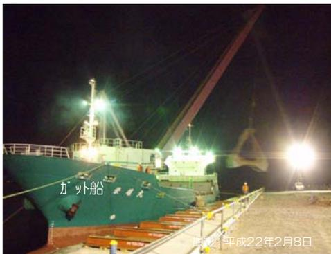
①船で運搬してきた路盤材を揚陸している状況。使用している岸壁は、空港外周護岸の一部である、ケツ式護岸。
