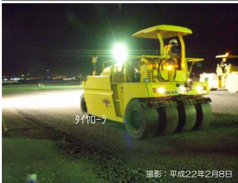
④敷き均しを行った後、タイヤローにて1次転圧を行います。1次転圧では、路盤材が十分に締め固まるよう転圧を繰り返します。
