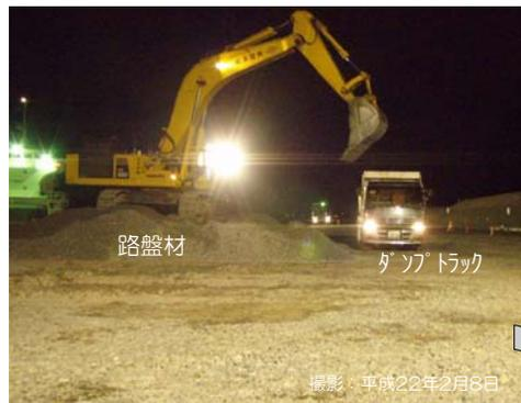
②揚陸した路盤材をダンプトラックに積み込んでいる状況。積み込み後、施工箇所へ運搬します。
