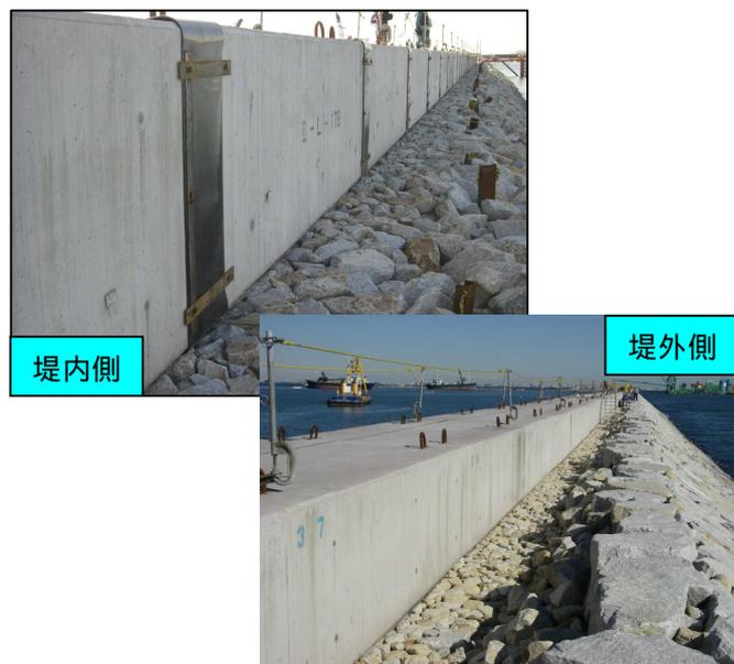
堤内側のブロックとブロックの境目に見える黒い板状のものは防砂板と呼ばれるものです。堤外側には被覆石が設置されている状況です。
