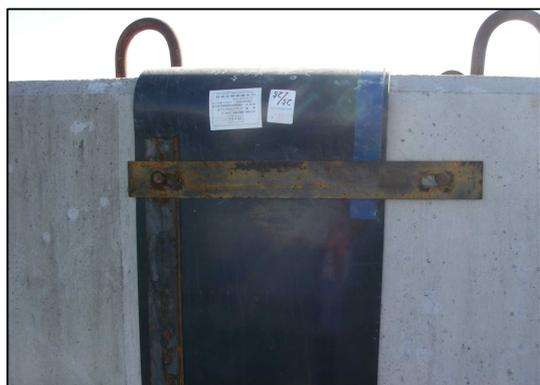
ブロックに設置した防砂板は雨や波の影響でブロックの隙間から埋立土砂が流出するのを防止します。
