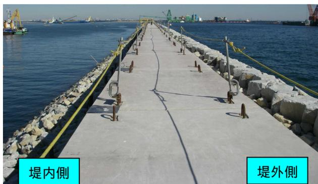
埋立護岸部では捨石の均し作業が終わった箇所上部ブロック（下段）の据付を行っています。
