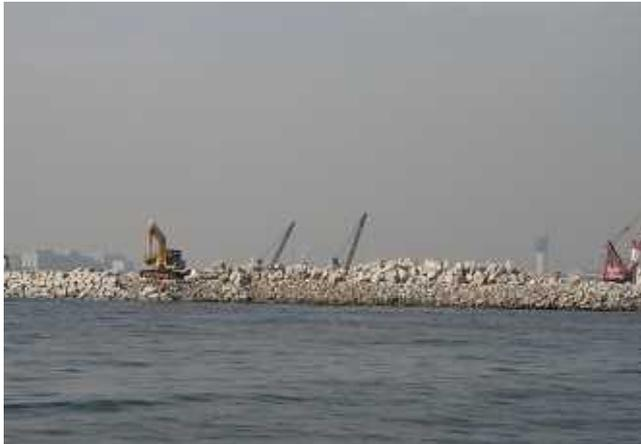
9月中旬に捨石マウンドが概成し、捨石の投入は大方、終わりましたが、現場では被覆石の設置作業が続いています。被覆石は捨石マウンド上または捨石マウンド外側表面に設置される大型の石(1トン/個)です。捨石が波浪などにより洗掘されるのを防止するために、捨石よりも大きい石で捨石マウンドの表面を覆います。
