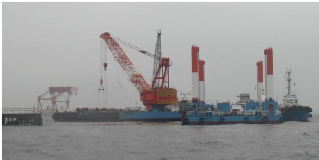
導材台船(写真中①)により基礎杭の打設位置を決めて、起重機船(写真中②)によって杭を打設していきます。
