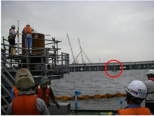
写真は、基礎杭(下杭)の打設が終わり、杭位置を確認している状況です。
