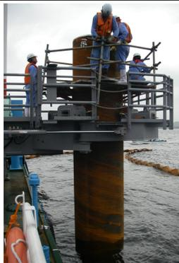
導材台船に付いているパイルキーパー(左写真中①)を使用することにより、高い精度での打設を可能にします。これは一本杭打設と同様の方法です。
