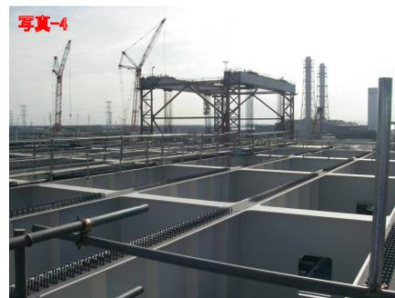
写真の中央に写っているのが、平成19年10月25日の現場日記でもご紹介しました下部ジャケットに上部ジャケットを載せる専用クレーンです。最大約1,100tの上部ジャケットを吊り上げることができます。
