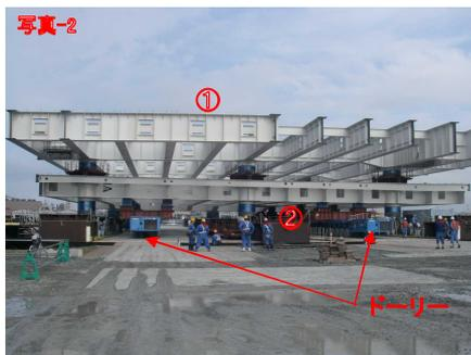
北九州で製作された上部ジャケット2基（最大2,200t）を台船から専用のドーリーで水切り（陸揚げ）している状況です。青く見えるのがドーリーで富津ヤードでは1台25.9mのドーリーを6台使用してジャケットを移動します。また、ドーリーにはジャッキが付いており地面に起伏があってもジャケットを水平に保つことができます。
