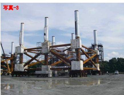
下部ジャケットの組立を行っている状況です。所々にある白いシートで覆った箱は、鋼管同士を溶接している場所で風雨による影響を少なくし、溶接の品質を確保します。
