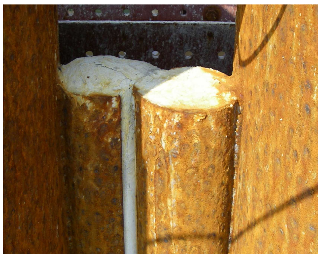
写真-5 モルタル注入完了
