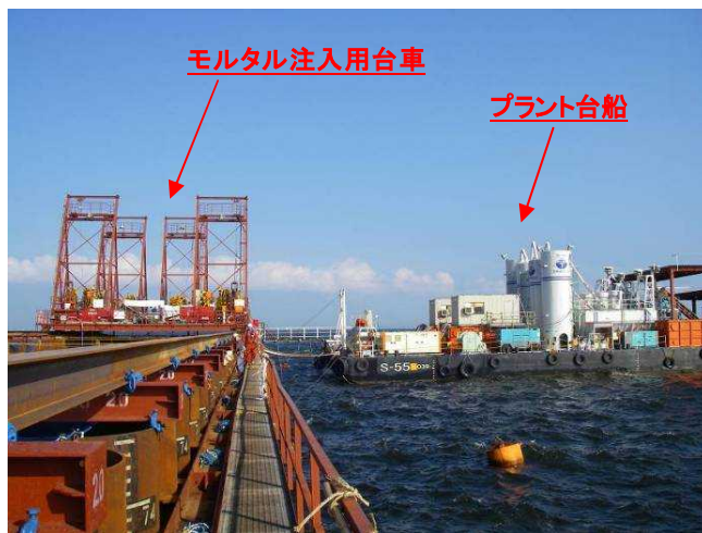
写真-1 作業全景
