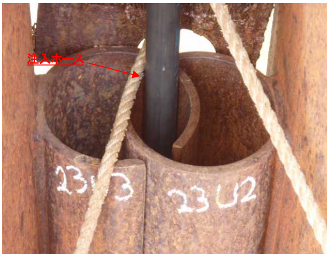
写真-4 注入ホース挿入状況
