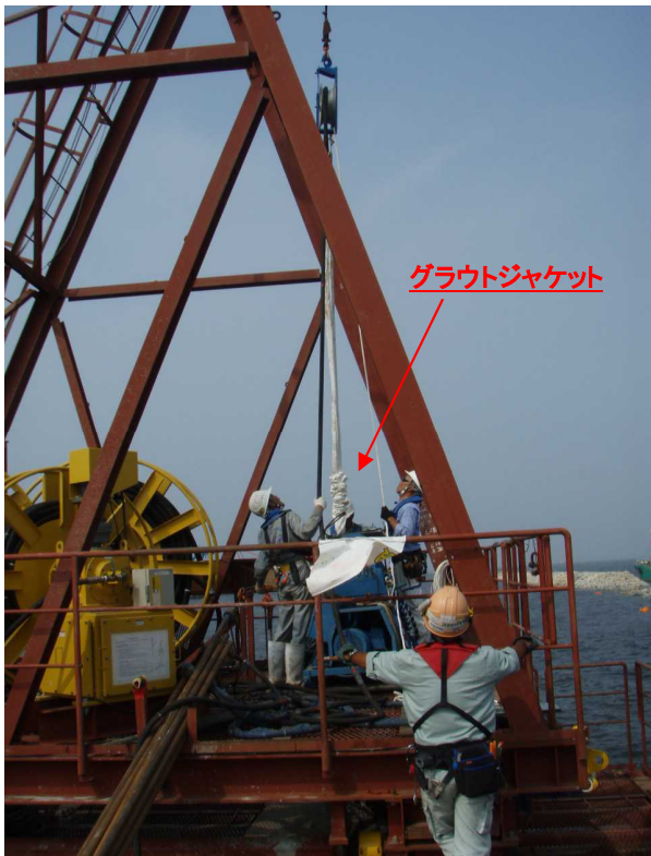
写真-3 モルタル注入状況
