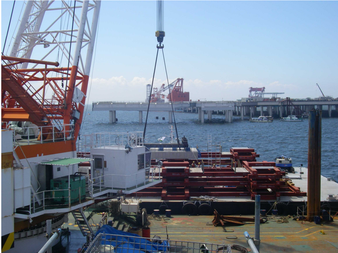
図-5・6 P Ca床版を吊りあげる神翔300
