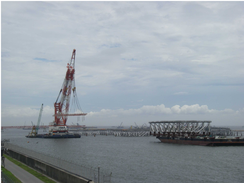
図-4 ジャケット据付の準備に入る神翔1600
