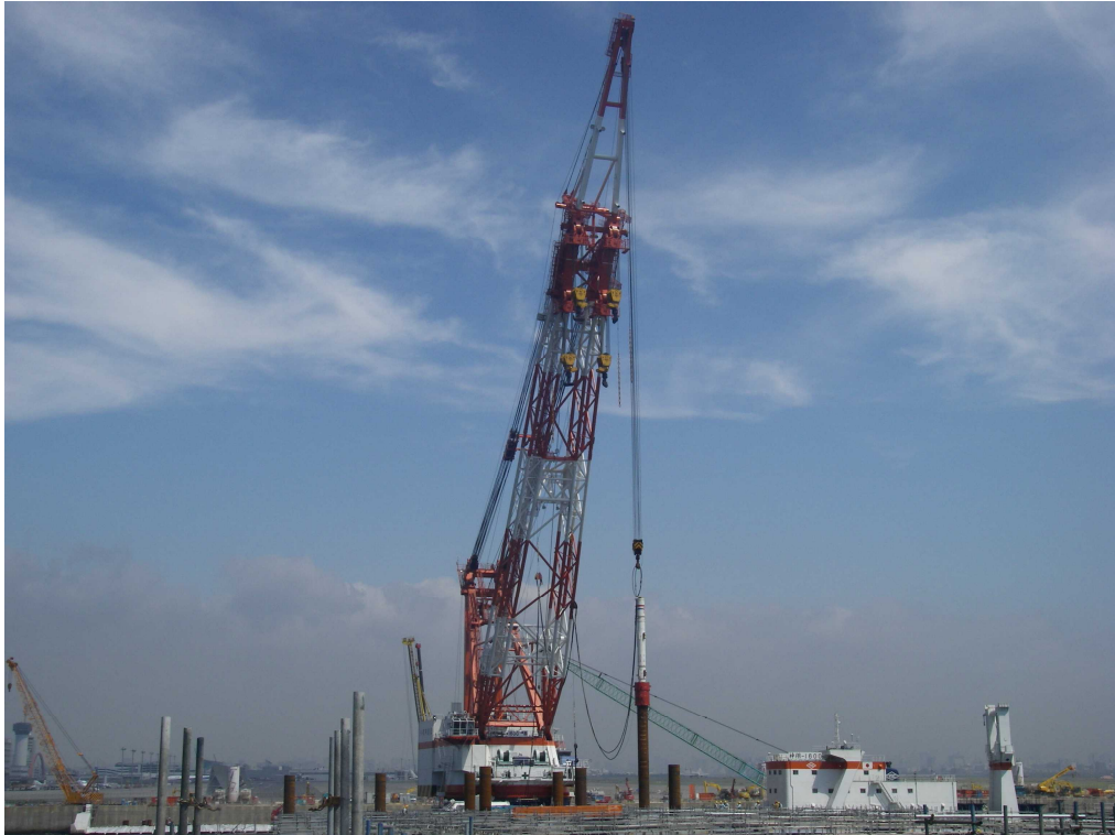
図-3 ジャケット基礎杭を打設している神翔1600
