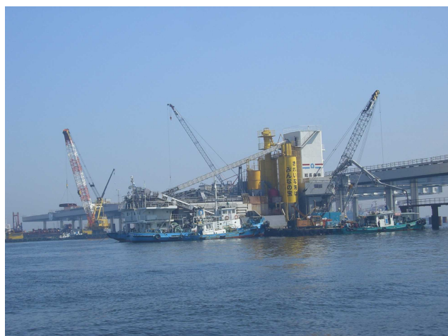
杭とジャケットを固定する工事（ミキサー船）
