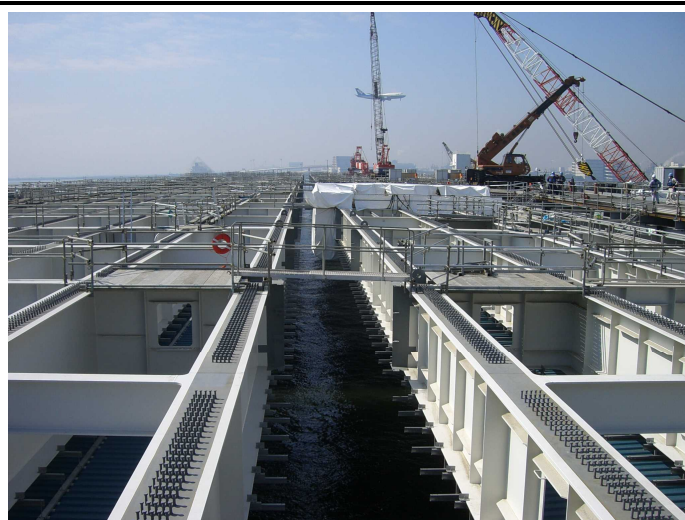
ジャケット同士の隙間（これらを繋ぎます）
