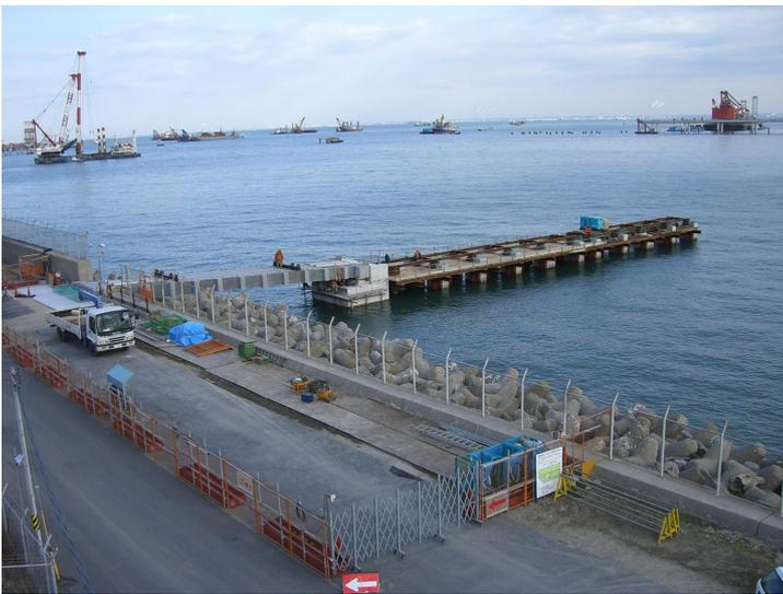
渡り橋を架設したのち、桁の位置を油圧ジャッキを使用して慎重に調整します。
