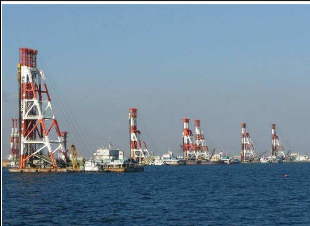
SCP船（サンドコンパクション）現在、8隻の船が稼働中です。SCP工全盛期には、13隻の船が稼働していました。昼夜問わず施工しています。まもなくSCP完工のカウントダウンです。
