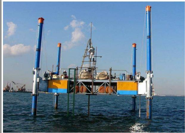
SCP工後のチェックボーリングです。地盤改良後、所定の強度を得られているかどうか調べています。地盤を所定の深さまで掘削し、重さ約63kgのハンマーを約76cmの高さから自由落下させます。先端に付いているサンプラーが規定貫入量の30cmを打ち込むのに要する落下回数（=N値）を求め強度を確認しています。
