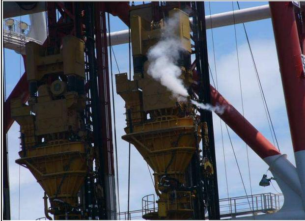
SCP船のパイプロです。パイプ内に砂を投入し、パイプロの振動とパイプ内のエア給気により砂を地盤の中に排出しています。現場では、エアの排気音が響いています。
