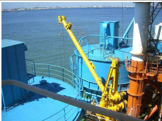
セメントスラリー貯蔵タンク
