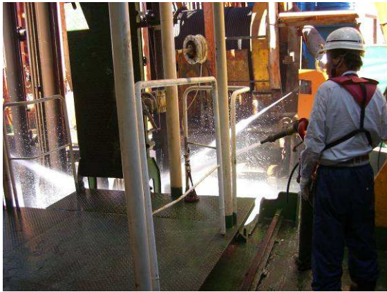
処理機に付着する粘性土を落とす様子 (処理機引き上げ時)
