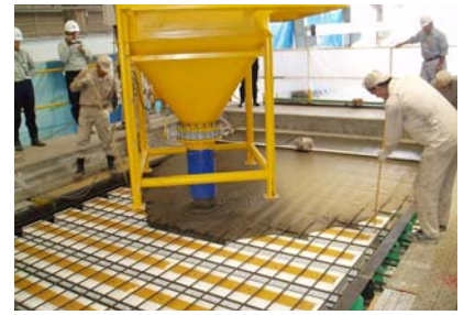
写真-1 UFC床版の打設状況
