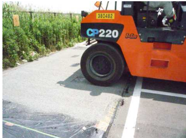
写真-3 タイヤローラによる骨材転圧状況
