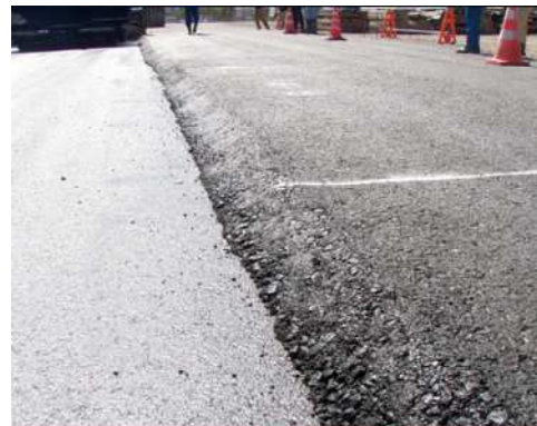
写真-1 コールドジョイントの状況
