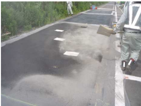
写真-2 7号砕石散布状況
