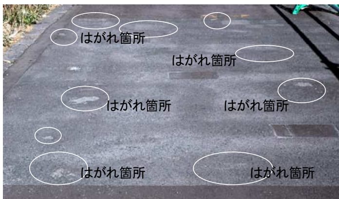
写真-5 6ヶ月養生後③工法 路面状況
