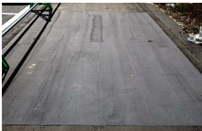
写真-7 6ヶ月暴露後の⑥工法 全景
