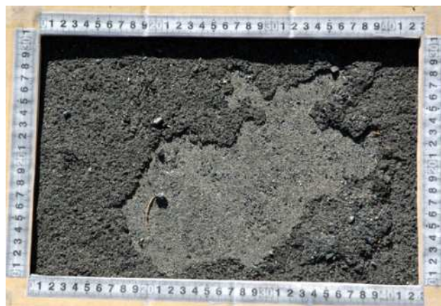
写真-6 はがれ箇所状況写真
