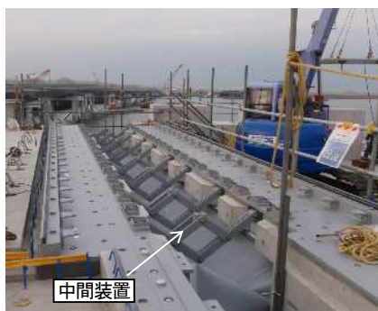
写真-7 DPジョイントの据付状況
