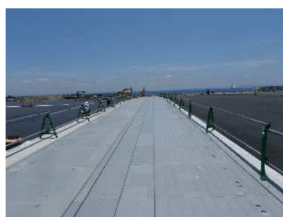
Rジョイント設置完了状況
