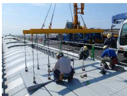
路面板の据付作業状況
