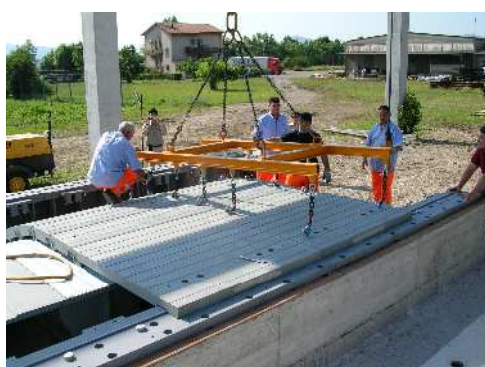
R ジョイントの仮組試験
