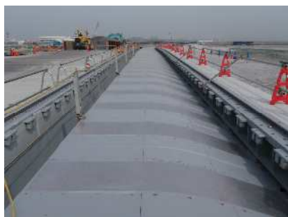
支持架台の据付状況
