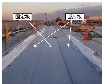
写真-7 DPジョイントの据付状況
