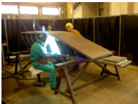
支持架台の溶接
