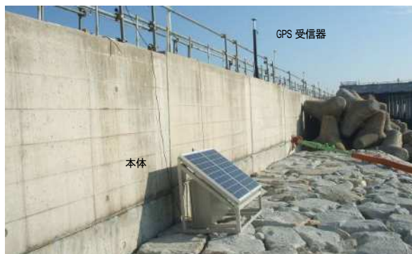
写真-4 リアルタイム GPS 沈下管理システム
