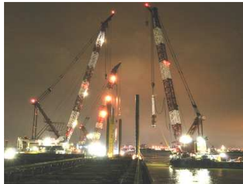
写真-2 500t 吊級杭打ち船による鋼管矢板の夜間打設作業（後行杭）
