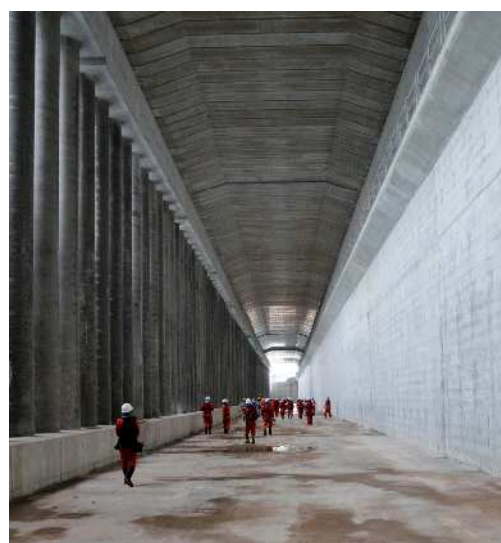
写真-10 消波護岸内部(通水前)
