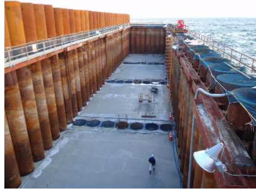
写真-5 井筒内部のドライアップ状況
