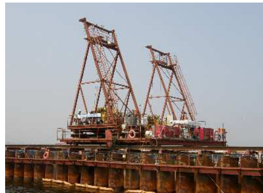
写真-3 鋼管矢板継手の掘削洗浄・モルタル注入用自走式台車
