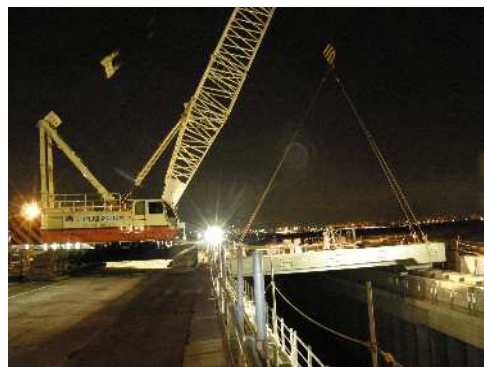
写真-13 PC 渡り桁の架設状況
