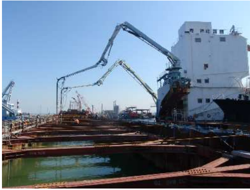
写真-4 CP 船による底盤コンクリート打設
