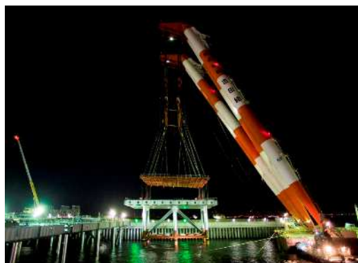
写真-12 3700t吊起重機船による18列JKTの据付
