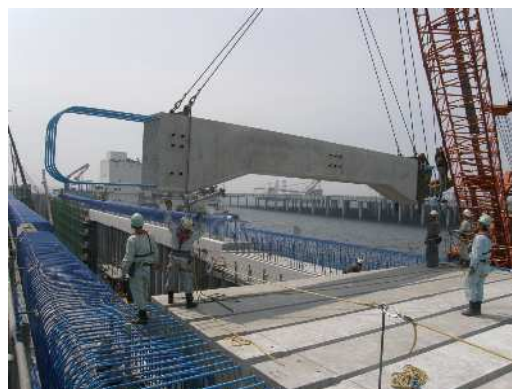
写真-9 上部PC桁架設状況
