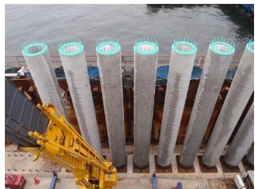
写真-8 スリット柱の建込み状況
