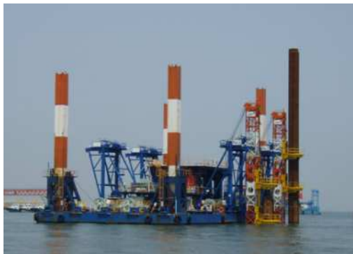
写真-1 水中リーダー式導材台船（先行杭打設）
