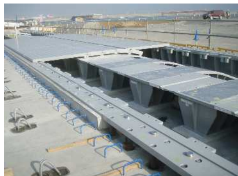
写真-14 伸縮装置設置状況
