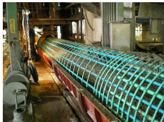
写真-7 スリット柱の製造状況
