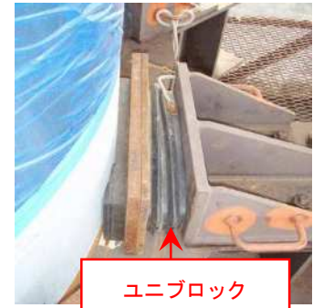
写真-5 ユニブロックによる固縛状況
