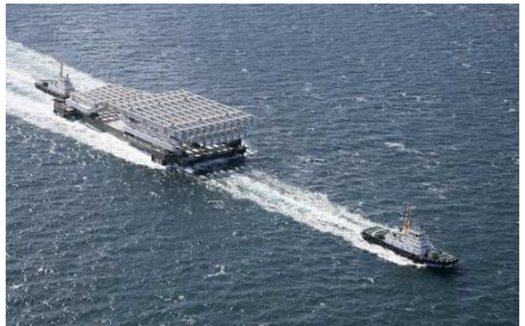
写真-4 上部ジャケット輸送状況（東京湾内）【長大物曳航状況】
