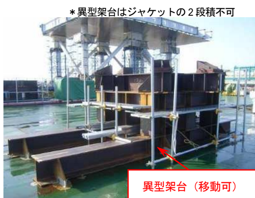
写真-6 上部ジャケット輸送用の架台 (左: 異型ジャケット用架台, 右: 標準架台)
