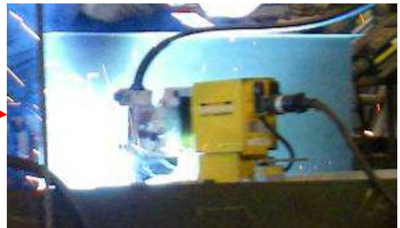
写真-3 首溶接施工状況写真
