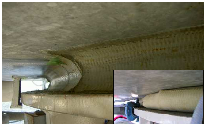
写真-7 エアーフエンス解体後状況(囲みは設置状況)
