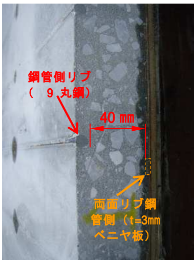
写真-5 二重管隙間充填状況
