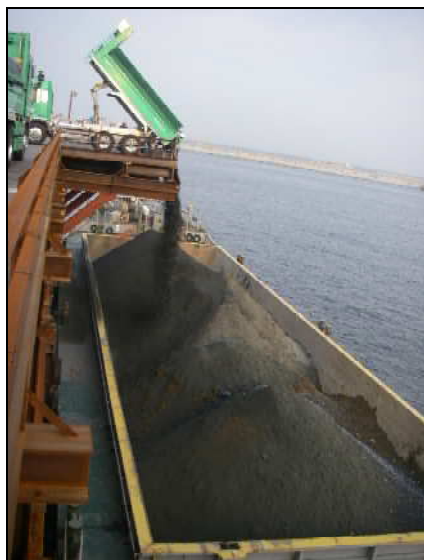
写真-5 仮設積出棧橋での発生土の積替状況
