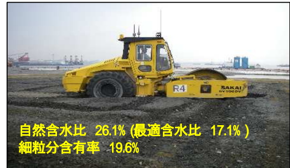
写真-4 陸上盛土施工での施工不可状態
