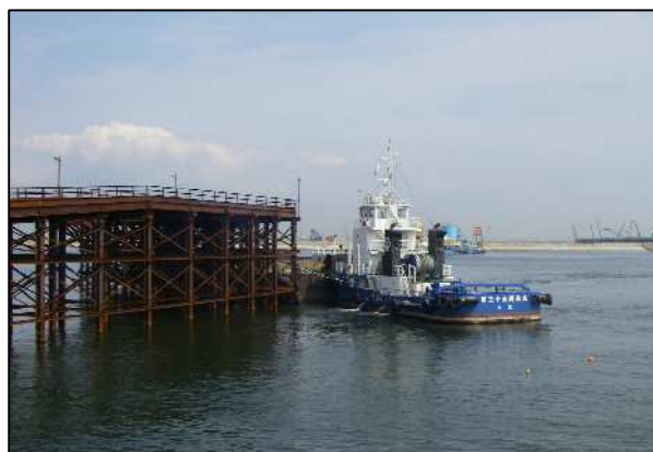
写真-1 東京国際空港内に整備した仮設積出棧橋
