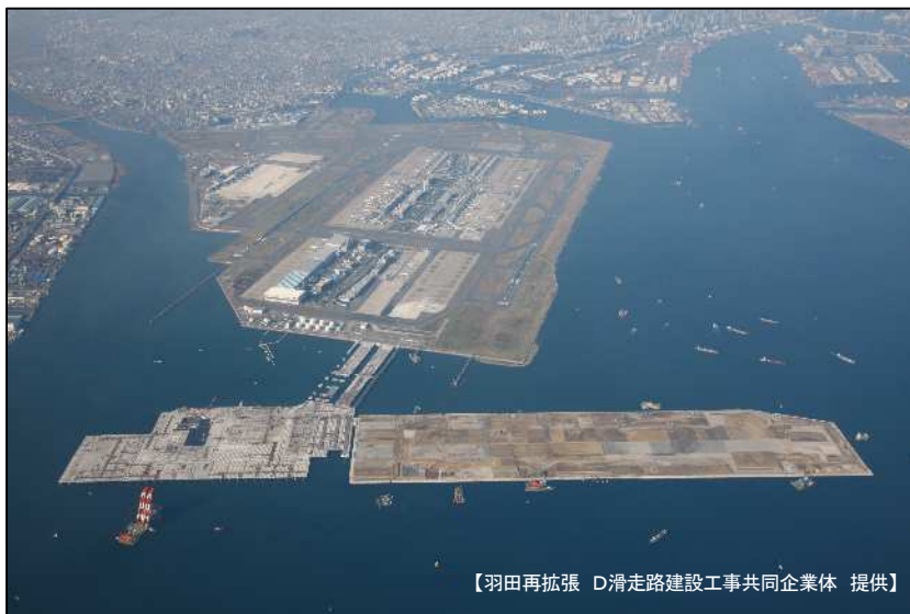
写真-6 供用開始に向け順調に工事が進捗しているD滑走路建設工事
