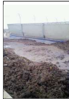
写真-2 高含水比土砂
