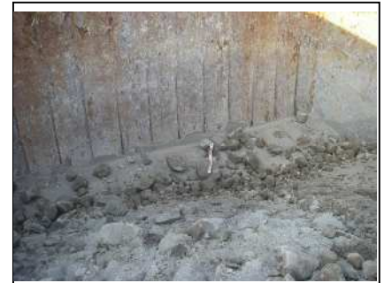
写真-3 最大粒径 30 cm以上の土砂
