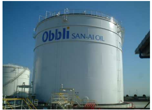
写真-2 9,800KL タンク
