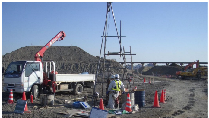
図-14 チェックボーリング実施状況
