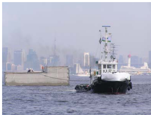
写真-5.1 ケーソン曳航状況
