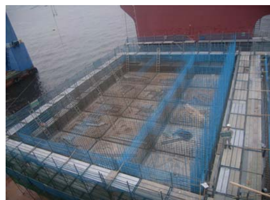
写真-4.1 鉄筋組立状況 (CW)
