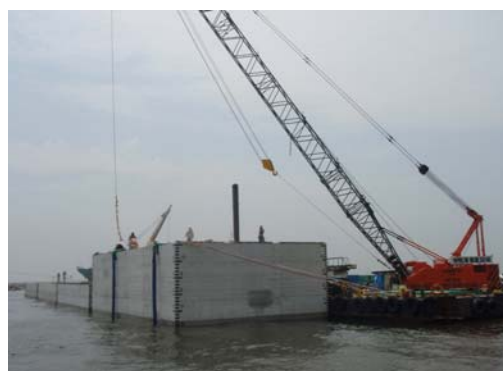
写真-5.2 ケーソン据付状況
