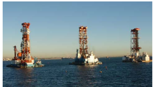
写真-3.1 CDM船による施工状況
