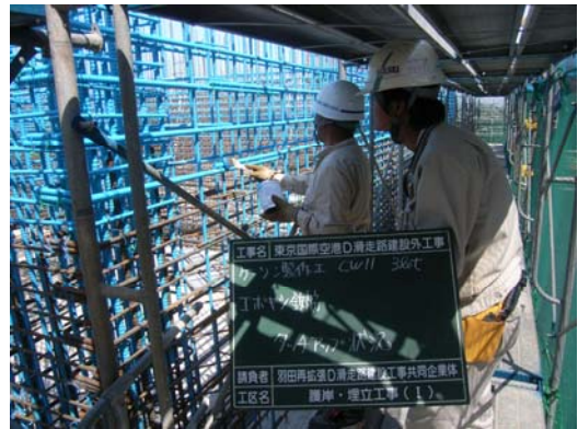
写真-4.2 補修作業状況
