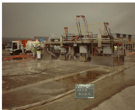
写真-4 ウォータージェット表面処理工
