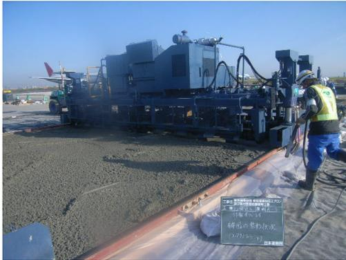
写真-8 締め固め
