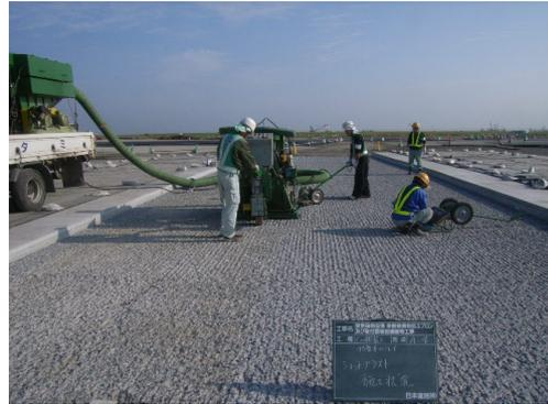
写真-5 ショットブラスト表面処理工
