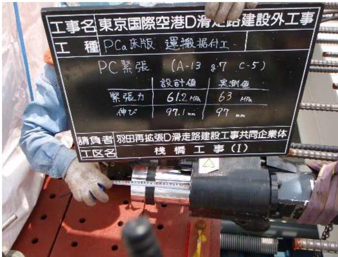
PC鋼より線伸量測定（緊張端）
