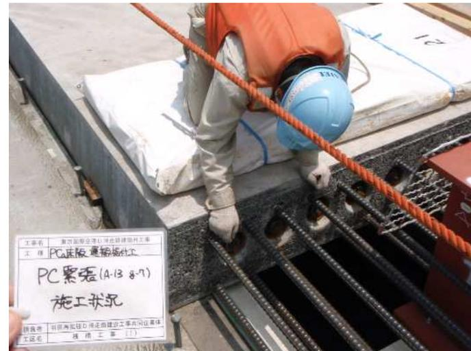
PC鋼より線伸量測定（固定端）
