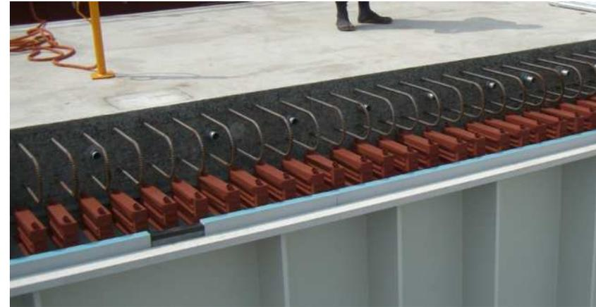
箱抜きボックス設置完了・PCa床版設置
